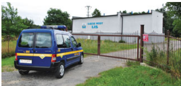
Fot. 6. Ujęcie wody – obiekt infrastruktury krytycznej
