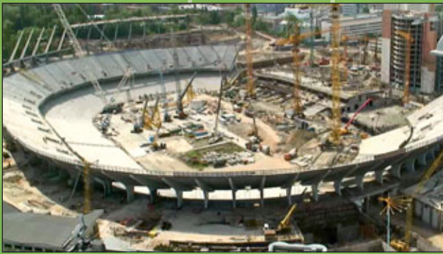
Fot. 2. Konstrukcja stadionu w Kijowie
