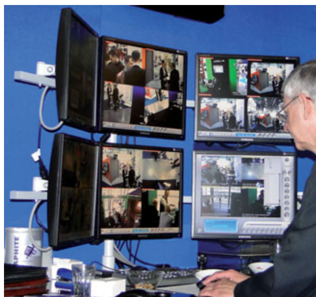
Fot. 3. Stanowisko testowania centralnej stacji monitorowania
