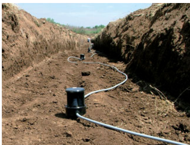
Fot. 1. System składa się z czujników połączonych kablem, które reagują na zmiany nacisku w obrębie niewidzialnej strefy detekcji
