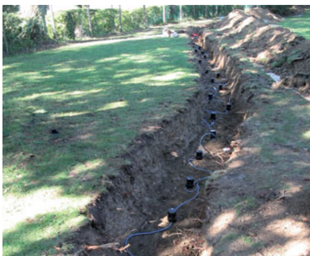
Fot. 3. Konstrukcja modułów umożliwia niemal dowolne wyznaczenie strefy detekcji, niezależnie od ukształtowania terenu, dzięki czemu system jest uniwersalnym rozwiązaniem dla każdej posesji
