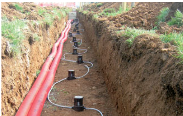
Fot. 2. Czujniki zakopane na głębokości ok. 60 cm pod ziemią wykrywają fale sejsmiczne generowane przez intruza na powierzchni – niezależnie od rodzaju wierzchniego podłoża, po którym się porusza
