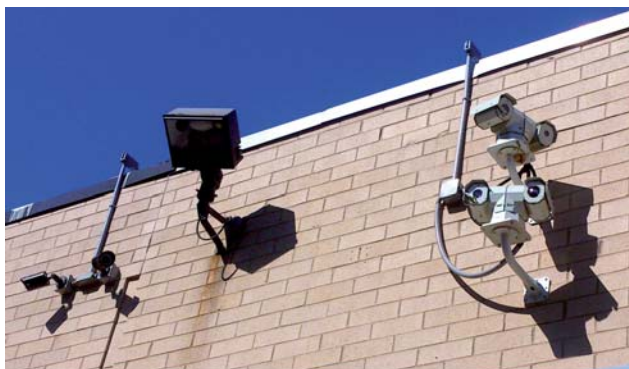
Fot. 3. Kamera laserowa i termowizyjna firmy Aventura
