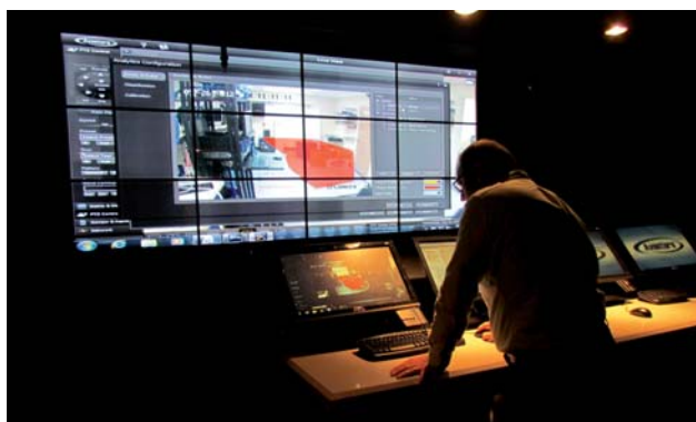
Fot. 5. Inteligentna analiza obrazu IVA w centrum nadzoru wizyjnego firmy Aventura
