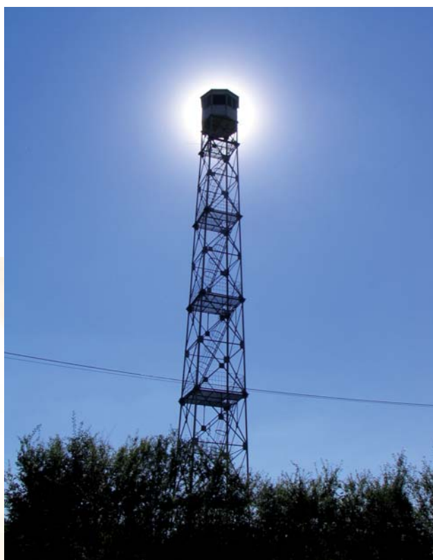
Fot. 1. Dostrzegalnia przeciwpozarowa wyposażona w kamerę z transmisją radiową
