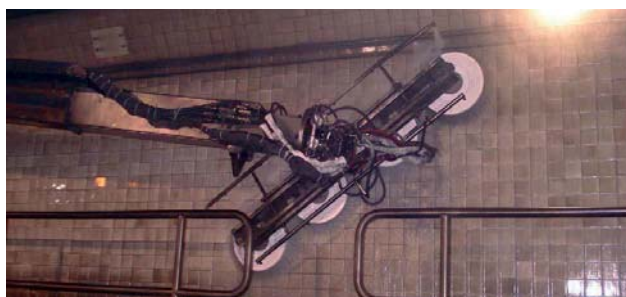
Fot. 2. Mycie tunelu. Omijanie czujek punktowych jest kłopotliwe
