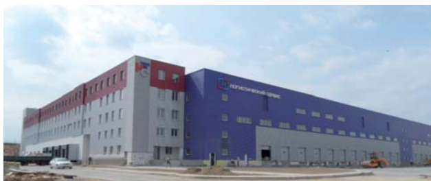
Fot. 2. AC2000 Lite zainstalowany w Distribution Center 24 zabezpiecza ponad 40 najważniejszych przejść
