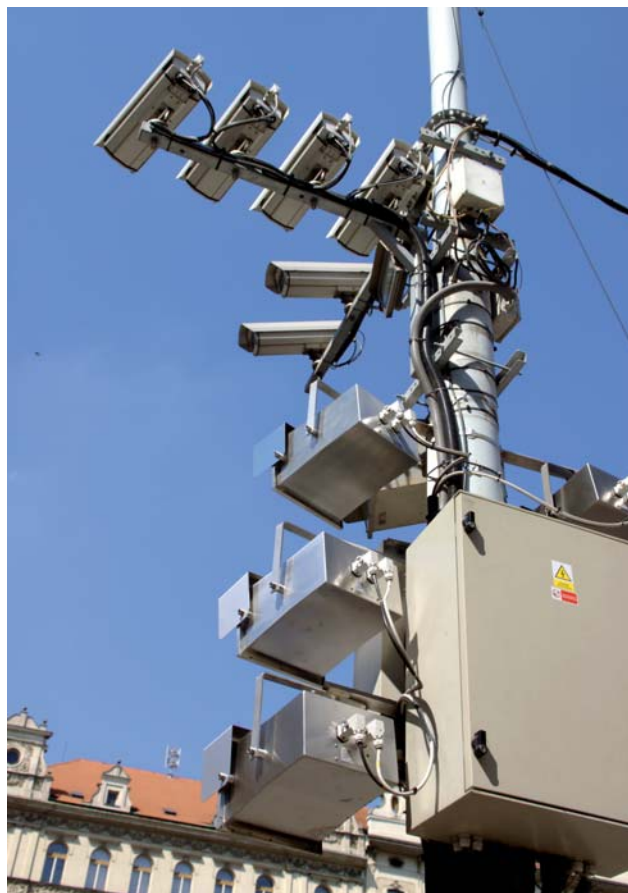
Fot. 1. Kamery do nadzoru ruchu drogowego na placu I.P. Pawłowa w Pradze (źródło: Aktron/Wikimedia Commons)
