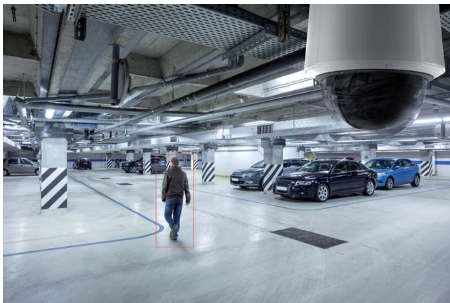
Fot. 5. Współpraca kamer stałopozycyjnych z obrotowymi – sygnał alarmowy, wywołany na skutek wykrycia obiektu przez kamerę stacjonarną, jest przekazywany do kamery obrotowej, która przejmuje śledzenie obiektu
