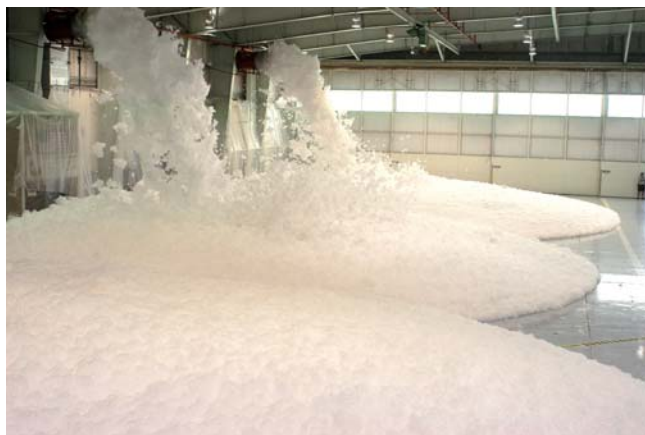
Fot. 4. Gaszenie pianą w hali
