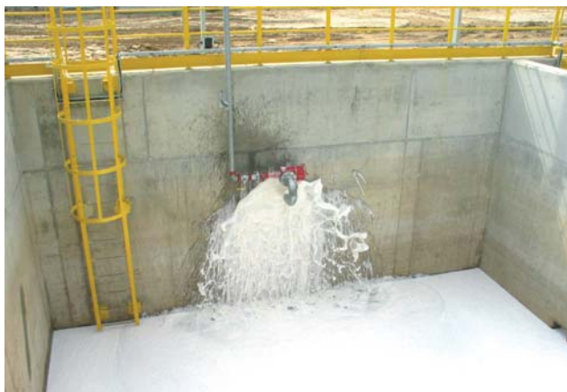
Fot. 3. Gaszenie pianą zbiornika paliwa ciężkiego (mazutu)
