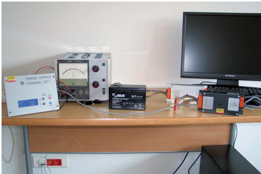
Rys. 4. Stanowisko do badań SSP: terminal centralki pożarowej typu CSP1TA oraz dwa koncentratory
