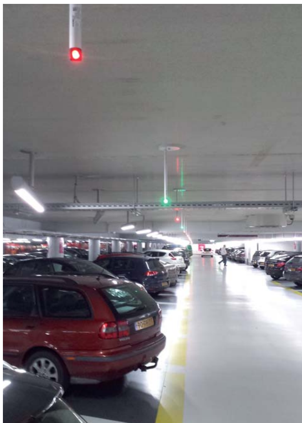
Fot. 3. System parkingowy przesyła strumień wizyjny do głównego serwera. Dane są wykorzystywane przez system rozpoznawania tablic rejestracyjnych. Możliwe jest śledzenie zachowań klientów i wychwytywanie określonych zdarzeń
