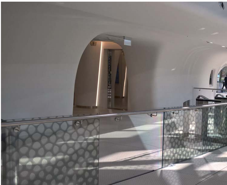
Fot. 1. Bramki szybkie SpeedStile FL EV 1800 zainstalowane w Warsaw Spire A
