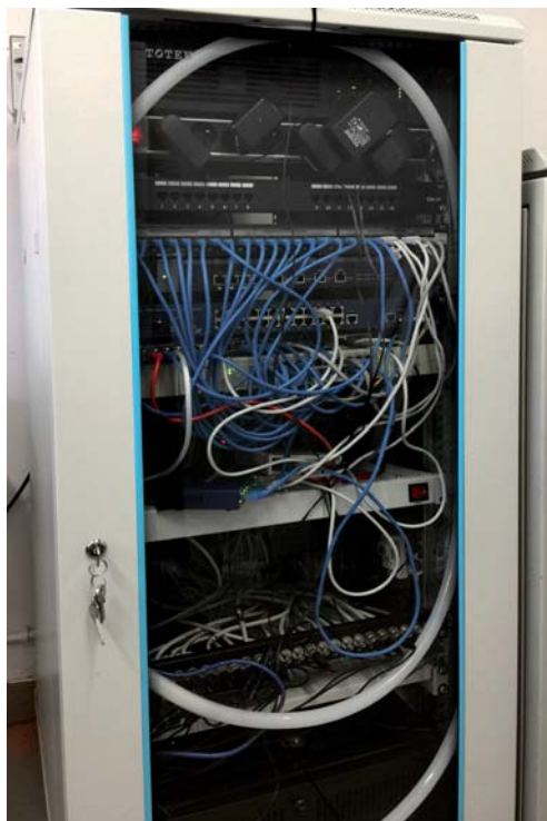
Fot. 4. PPROTENG TIRAGRO – system o długości 4 m, dostosowany do kubatury 2 m 3 (komory dużych pojazdów mechanicznych, np. autobusów, samochodów ciężarowych, maszyn budowlanych i rolniczych, duże szafy serwerowe i rozdzielcze)
