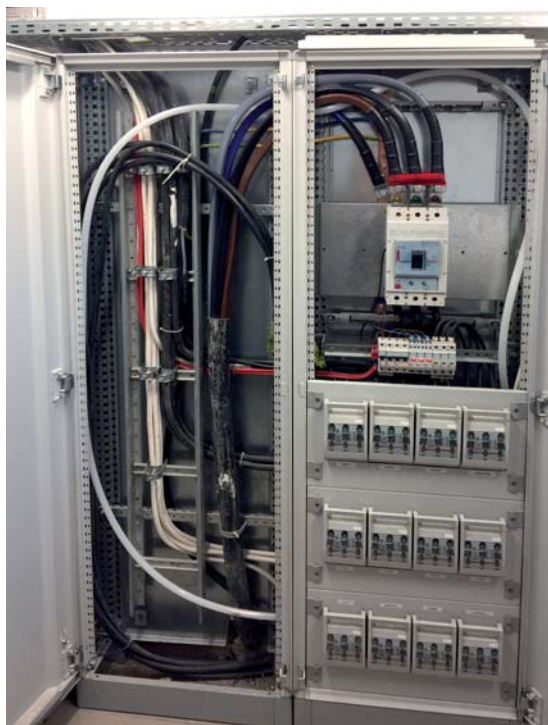
Fot. 2. PROTENG ELECTRO – system o długości 1 m, dostosowany do kubatury 0,5 m 3 (szafy rozdzielcze elektryczne i serwerowe)
