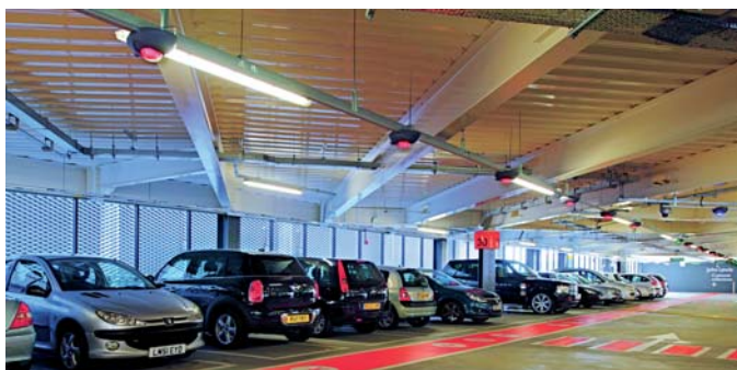
Fot. 2. Park Assist jest systemem, który oprócz wskazywania wolnych miejsc parkingowych pozwala na obserwację każdego samochodu pozostawionego na parkingu
