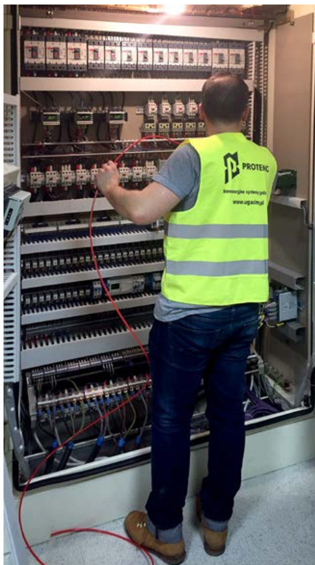
Fot. 2. Montaż systemu Proteng FM-200 Firetrace w szafie rozdzielczej
