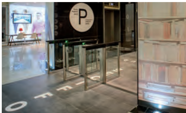
Fot. 2. Bramki uchylne SpeedStile FL s w budynku myhive Crown Point w Warszawie
