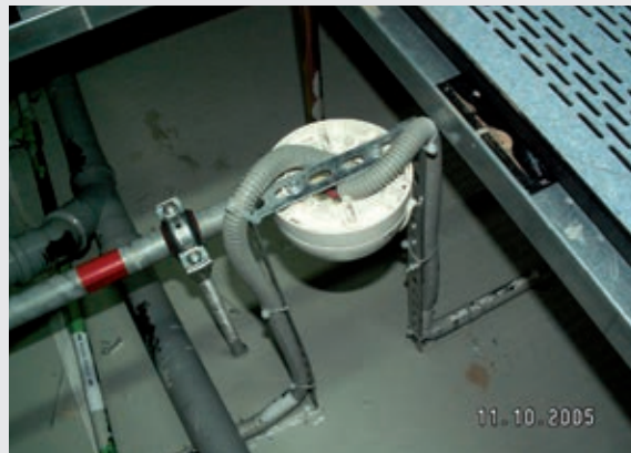
Fot. 4. Sposób montażu czujki nadzorującej przestrzeń podpodłogową
