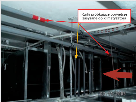
Fot. 2. Nadzorowanie przestrzeni międzypodłogowej
