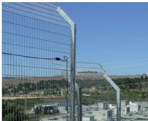
Fot. 3. Przykład instalacji sensorów VAF3 na ogrodzeniu panelowym
