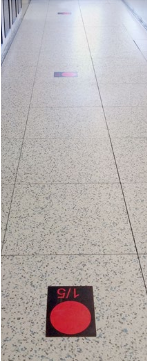
Fot. 3. Oznaczenia miejsca instalowania czujek
