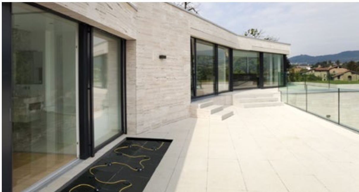
Rys. 3. System DEA SISMA CA instalowany pod chronioną powierzchnią
