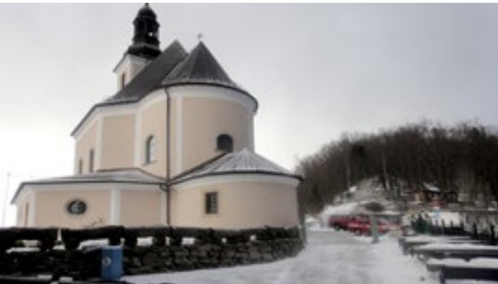
Fot. 1. Przykład zastosowania wysokociśnieniowej mgły wodnej (sanktuarium „Maria Śnieżna” na Górze Iglicznej)
