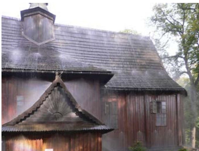
Fot. 2. Instalacja mgły wodnej w działaniu
