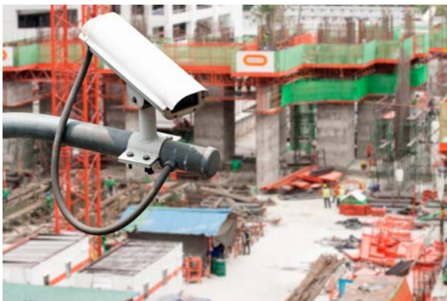
Fot. 2. Ochrona budowy
