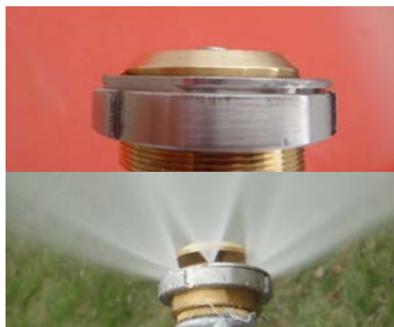
Fot. 4. Niskociśnieniowe głowice mgłowe (głowice grzybkowe) zastosowane w miejscach o dużym zapaleniu
