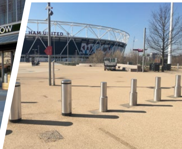
Fot. 5. Bariery statyczne i automatyczne przy Stadionie Olimpijskim w Londynie
