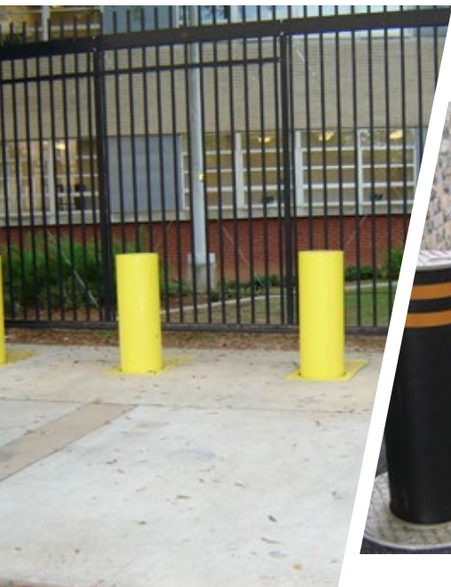
Fot. 1. Bariery antyterrorystyczne w centrum zarządzania kryzysowego w Atlancie
